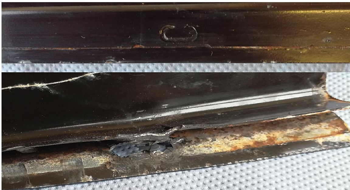
Obr. 21: Korozní testy přeplátovaného spoje, přítomnost Flange corrosion
